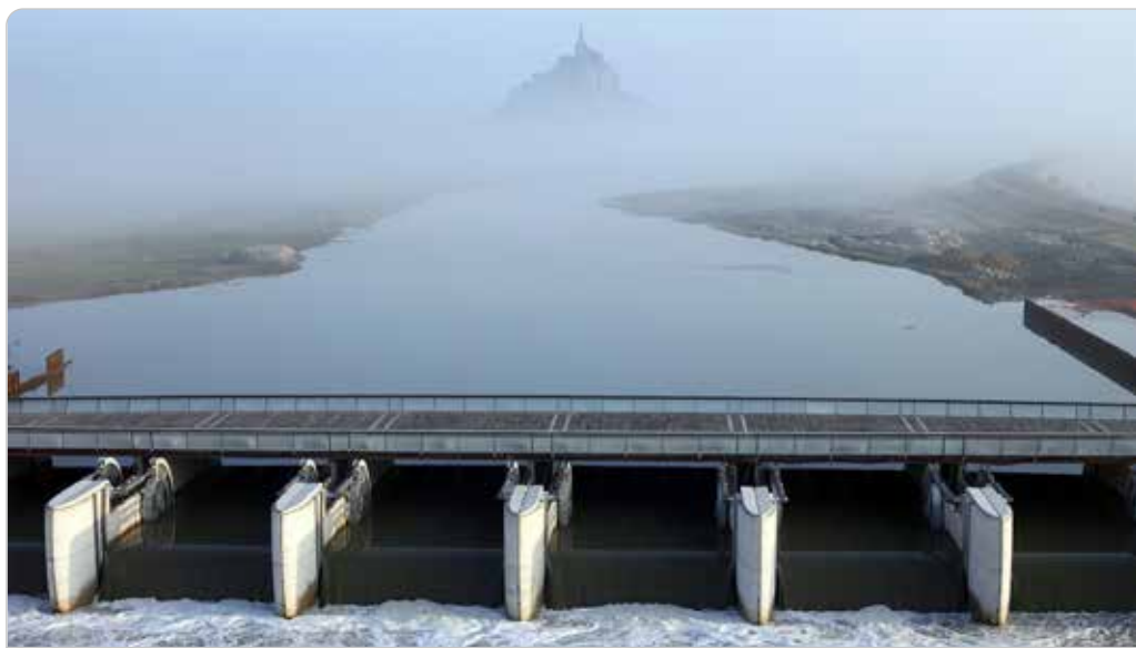
Grand prix de l'ingénierie française pour le barrage de la caserne sur le Couesnon - Programme de rétablissement du caractère maritime du Mont St Michel - © Thomas Jouanneau
